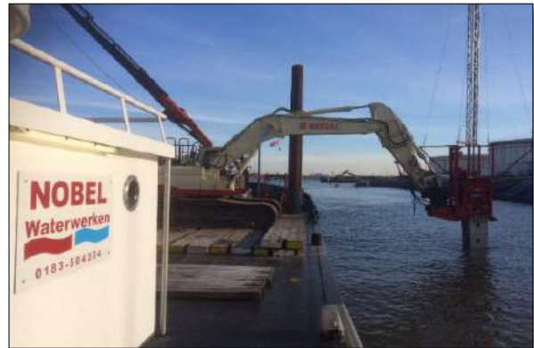
Uitvoeren dieptedetectie t.p.v. de waterbodem
