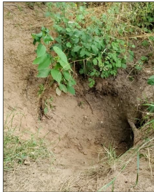
Afbeelding 33. Vluchtpijp t.h.v. camping Buitengewoon.
