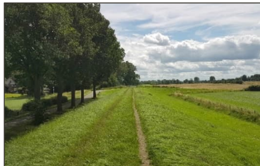
Afbeelding 4. Dijktracé met bomenrij vanuit het westen gezien (zuidelijk van Middelaar).
