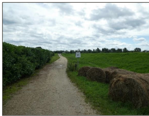
Afbeelding 6. Dijktracé ter hoogte van Middelaar.
