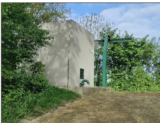
Afbeelding 14. Het gemaal westelijk van de voormalige steenfabriek.
