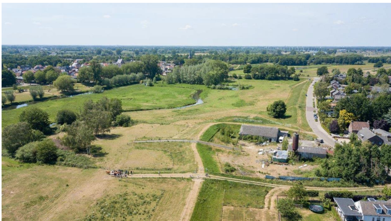
Figuur 3.2: Zicht op de huidige dijken met hoekig karakter en voormalige betonfabriek
